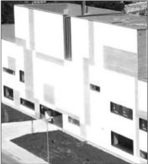
Edificio de la comisaría conjunta de Alcalá
